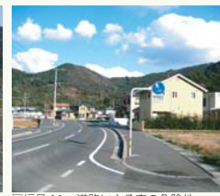
□幅員 16m 道路による車の危険性
