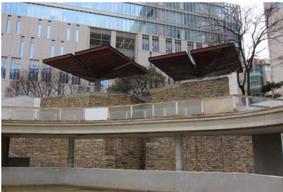
レイプ事件が発生し、立入禁止となっていた築山とウォーターデッキ
